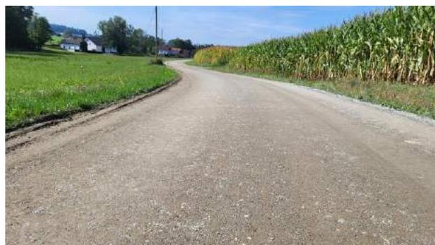
Dann wird in drei Lagen die Splitt-Bitumen-Emulsion aufgetragen.
