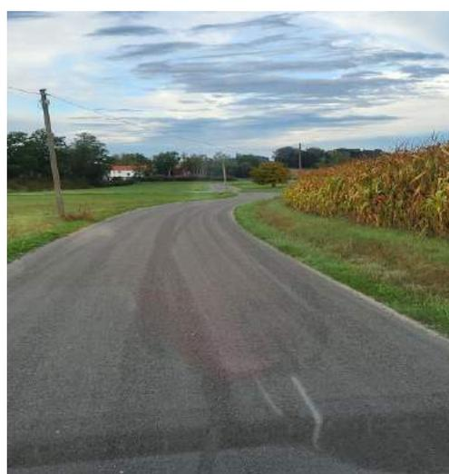
Die ausgeführte Oberflächenbehandlung ist eine reine Verschleißschicht; die Nutzungsdauer ist wesentlich abhängig vom Grad der Beanspruchung durch den darüber laufenden Verkehr; der Unterbau ist ausreichend frostsicher und tragfähig angelegt worden.
